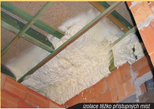
izolace těžko přístupných míst
