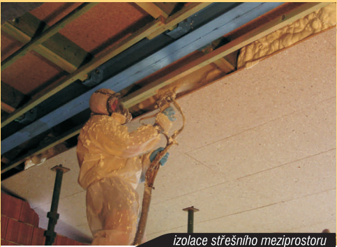
izolace střešního meziprostoru
