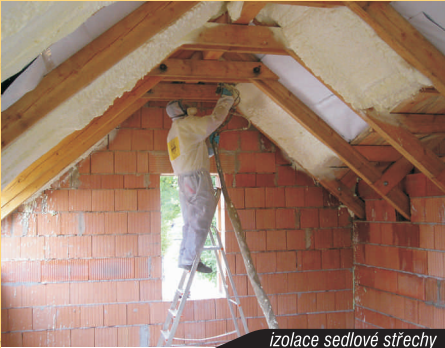
izolace sedlové střechy
