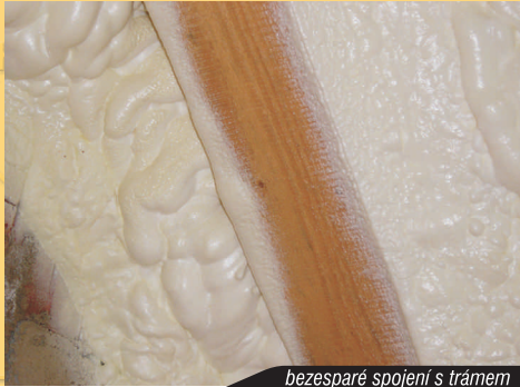
bezesparé spojení s trámem
