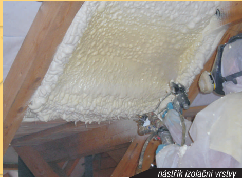
nástřik izolační vrstvy
